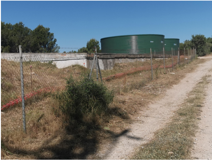
Foto1: Accés als dipòsits
