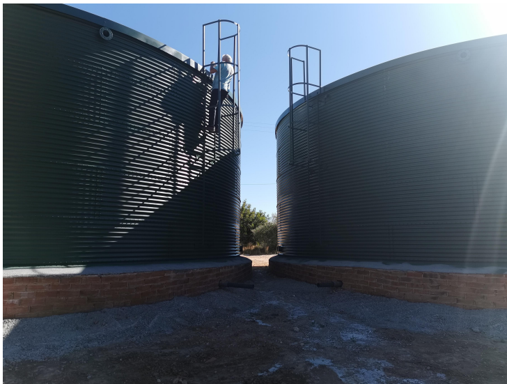
Foto 2: Accés als dipòsits i connexió entre ells
